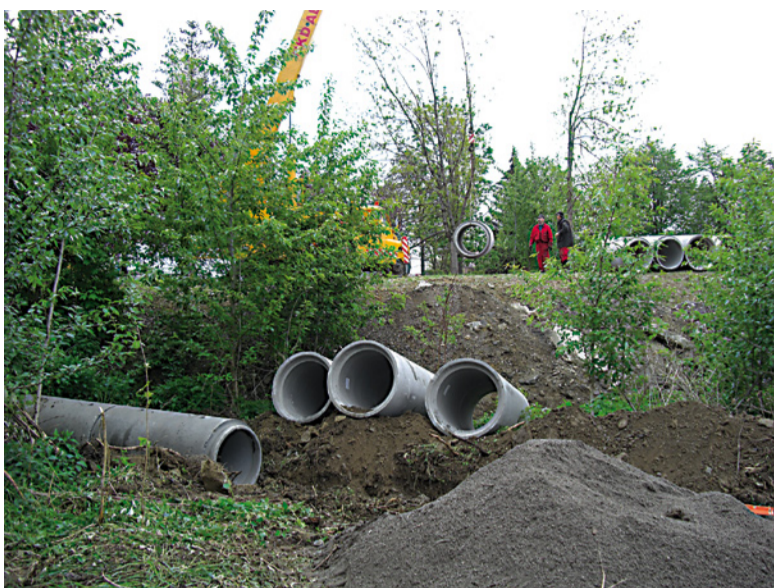
Práce pri prekrývaní potoka.
