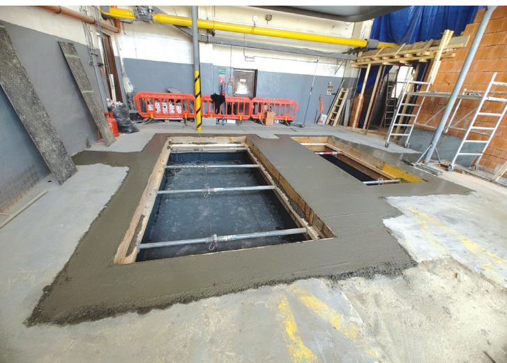
Priestory kotolne, v ktorých sa pripravuje priestor pre nové efektívnejšie technológie na výrobu elektriny a tepla.
