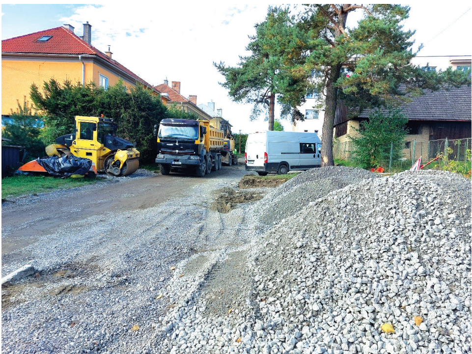
Rekonštrukcia Ulice Komenského.
