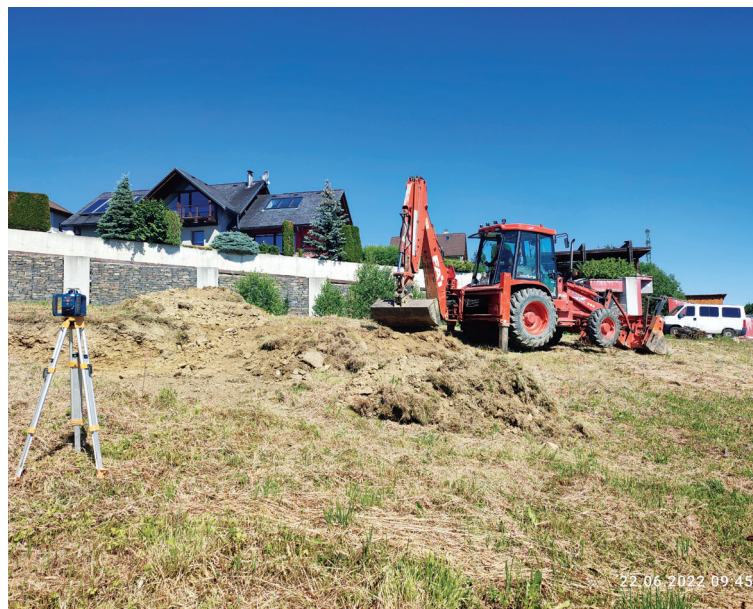
Začiatok prác na oddychovej zóne.
