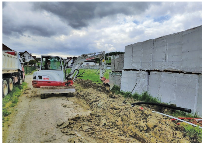
Príprava plochy prekládkovej stanice na betónaž.
