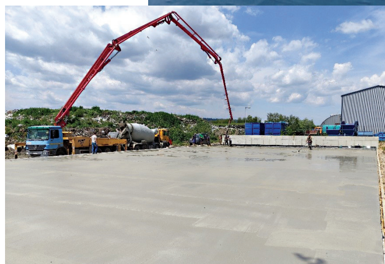
Príprava plochy prekládkovej stanice na betónaž.
