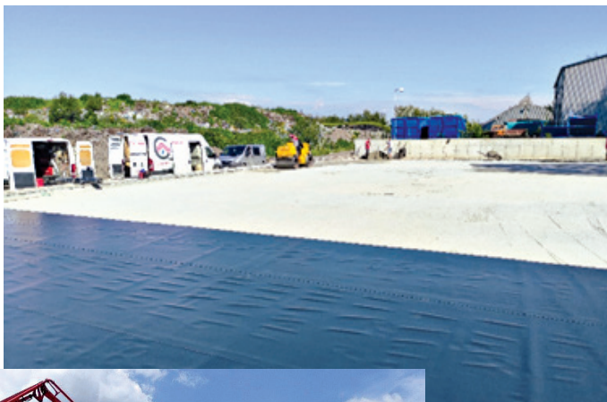
Príprava plochy prekládkovej stanice na betónaž.
