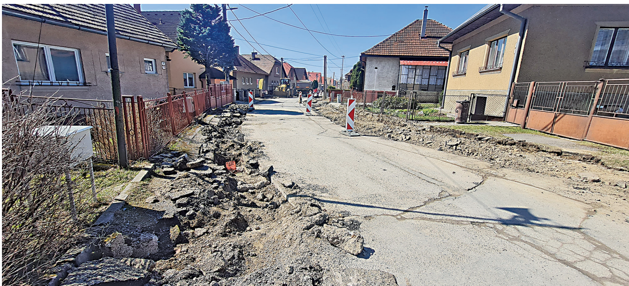
Ulica Červeného kríža prejde kompletnou rekonštrukciou – telesa cesty i chodníkov.
