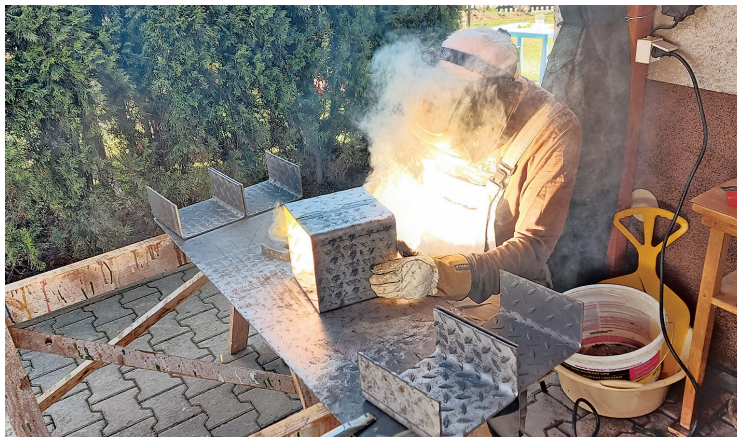
Na ihrisku brigádujú aj otcovia, ktorí fandia svojim synom, že sa pustili do tohto diela. Jeden z nich pri zváraní pätníkov na uchytenie konštrukcie pod mantinely.
