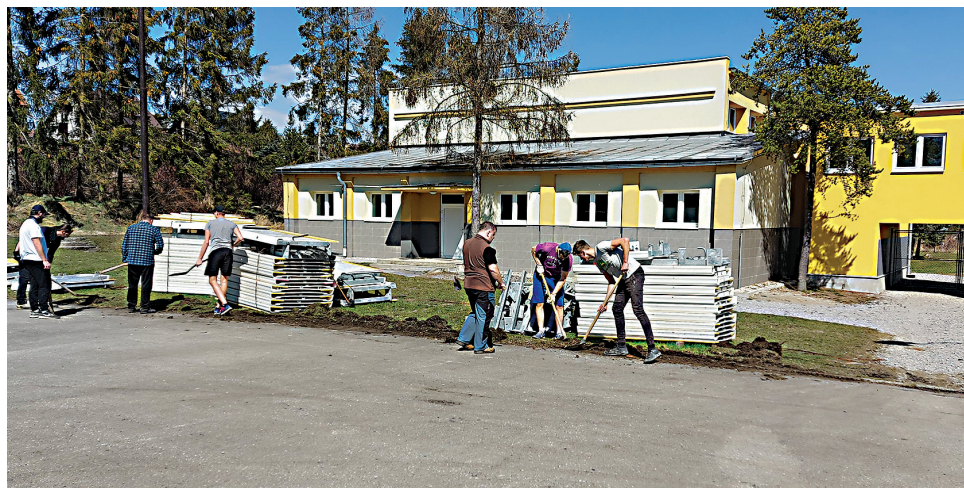
Práce na budovaní multifunkčného ihriska v Námestove sa na jar rozbehli.
