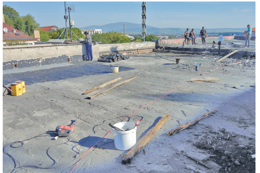
Priaznivé počasie uplynulých dní stavbárom pri rekonštrukcii strechy na mestskom úrade prialo. Foto: (msú)
