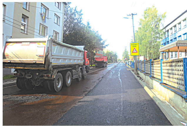
Rekonštrukcia Komenského ulice.
