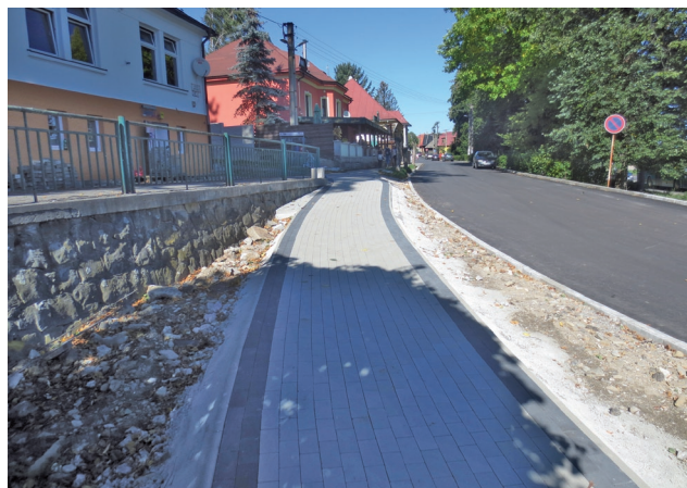
Nový chodník pod kostolom prispeje k bezpečnosti chodcov.
