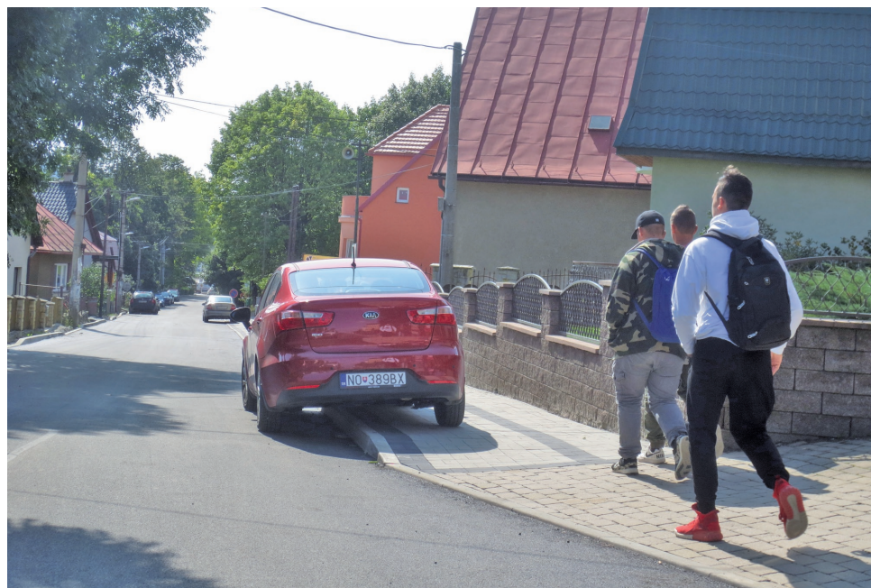
Vynovená časť Ulice Mieru od gymnázia pod kostol s rozšíreným chodníkom.
