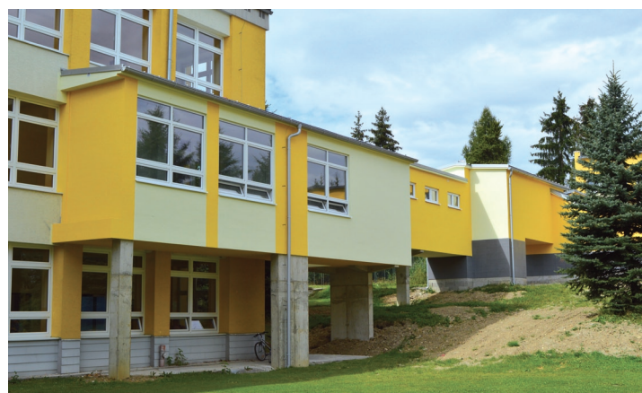
Spojovaciu chodbu ZŠ s telocvičňou na Komenského ulici ocenia žiaci i učitelia najmä v chladných mesiacoch.
