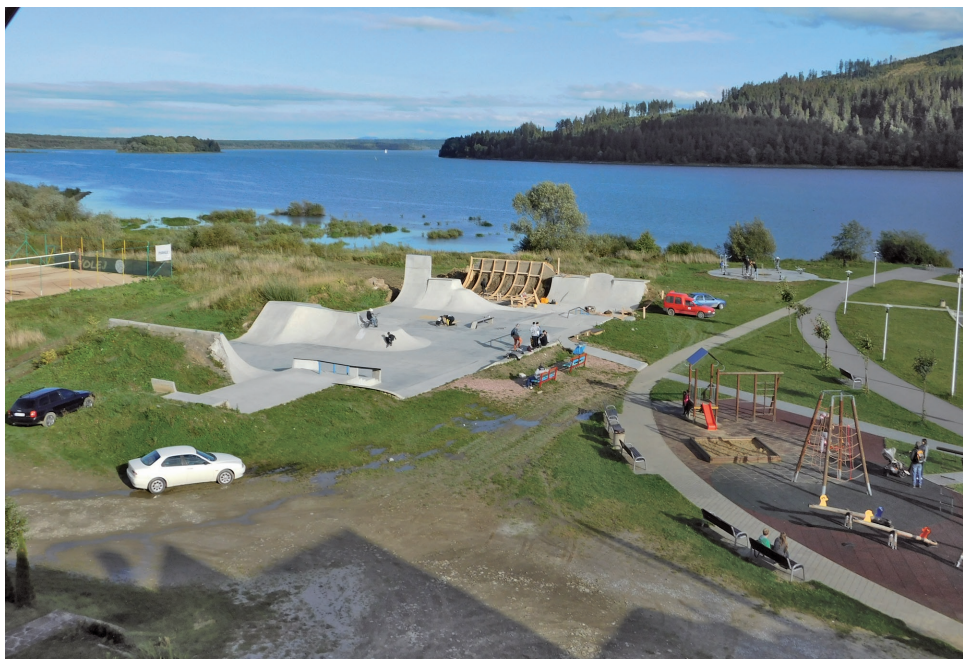
V týchto dňoch prebiehajú práce na dobudovaní poslednej rampy SKATEPARK-u na nábreží.
